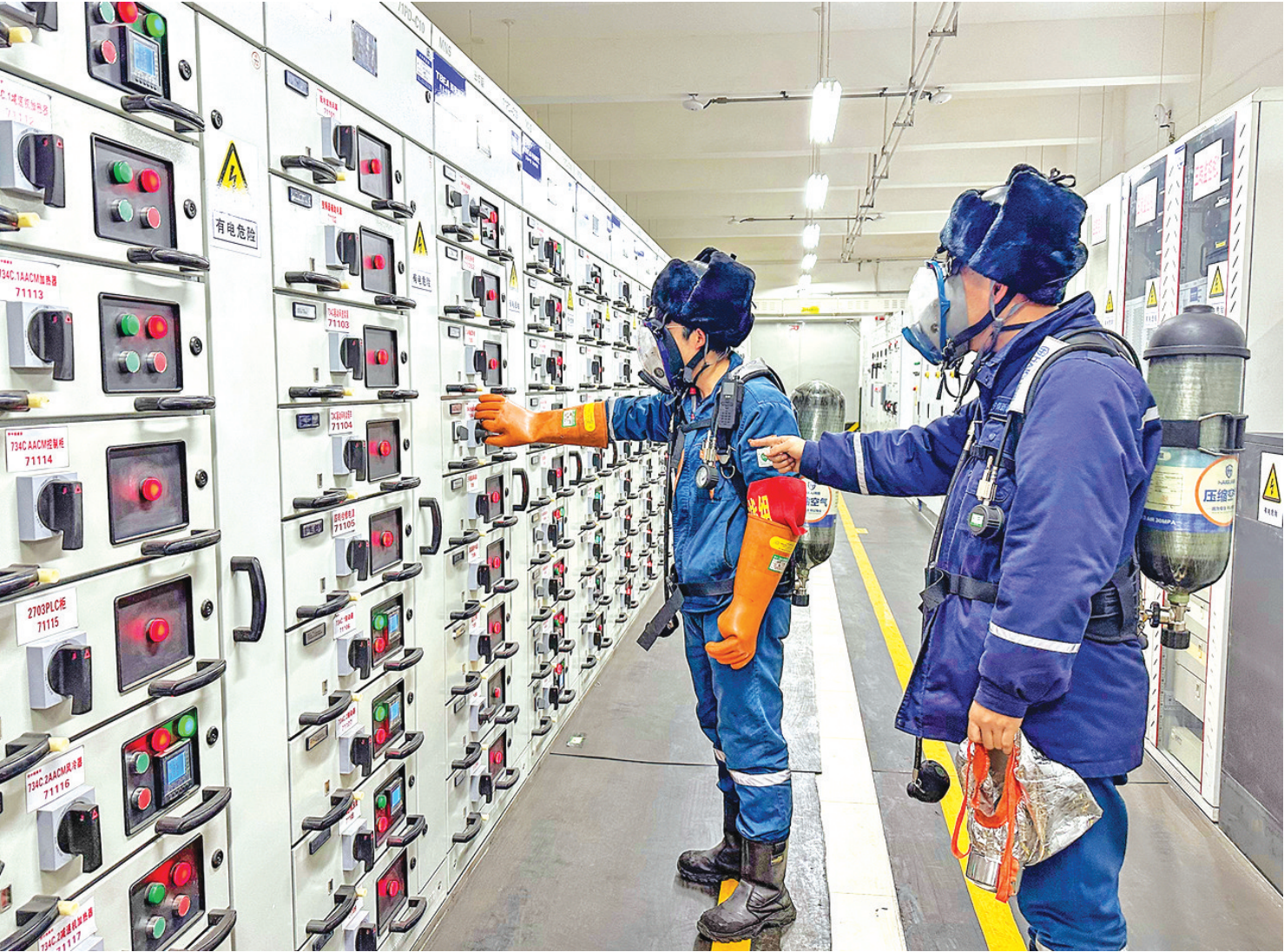
1月24日，准东经济技术开发区中煤建安工程集团有限公司新疆分公司将二矿运营厂采购新式磁吸式S型热气溶胶灭火贴等灭火设备，安装在21个低压配电柜及63个非防爆配电箱内，保证电气设备在发生电气火灾时能够第一时间对火源进行扑灭，为电气设备安全和职工生命财产安全保驾护航。图为工作人员在安装调试灭火设备。 □刘亮杰摄
