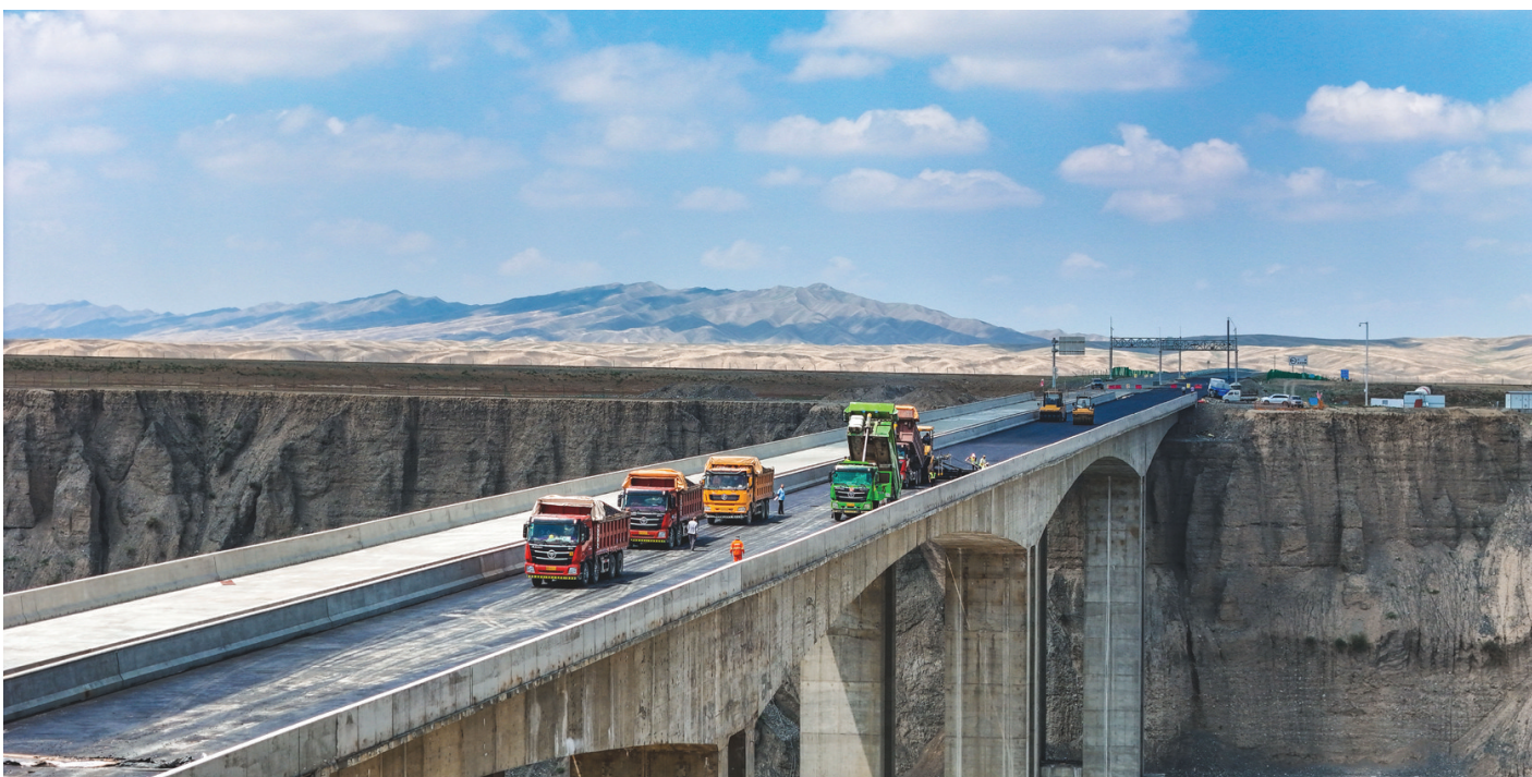
5月24日,工人在昌吉州西部南山伴行公路项目(一期)呼图壁河大桥工程施工现场作业。该项目线路全长69公里,全线采用一级公路设计标准,目前已进入收尾阶段,预计6月底达到通车条件。
