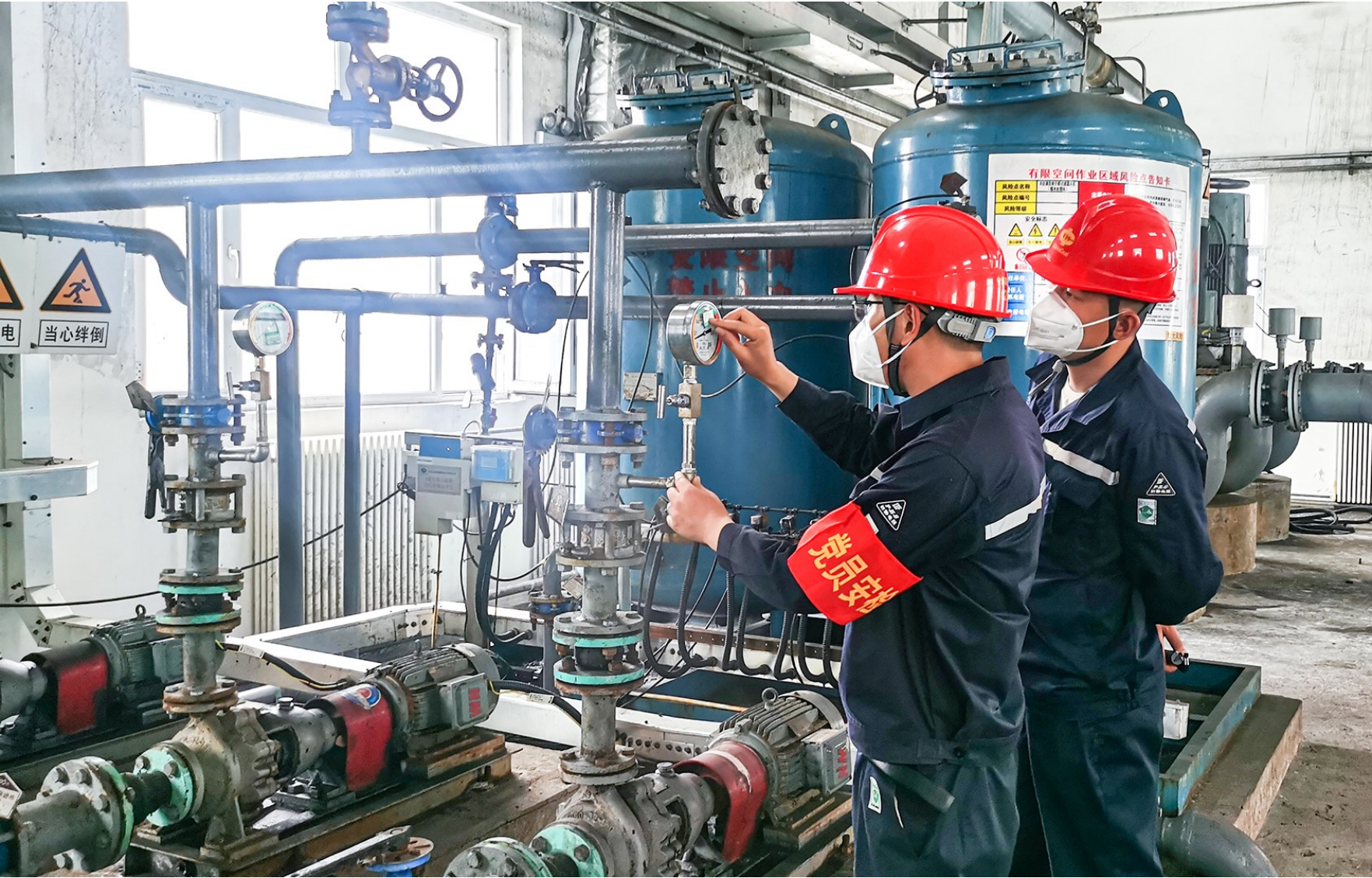
6月23日，准东经济技术开发区中煤建安集团新疆分公司北二电厂项目，员工在检查设备。连日来，该公司组织党员安监员、群监员对厂区机械设备、输煤皮带、配电室等重点场所进行安全检查，及时将各类隐患消除在萌芽状态，为安全生产保驾护航。
