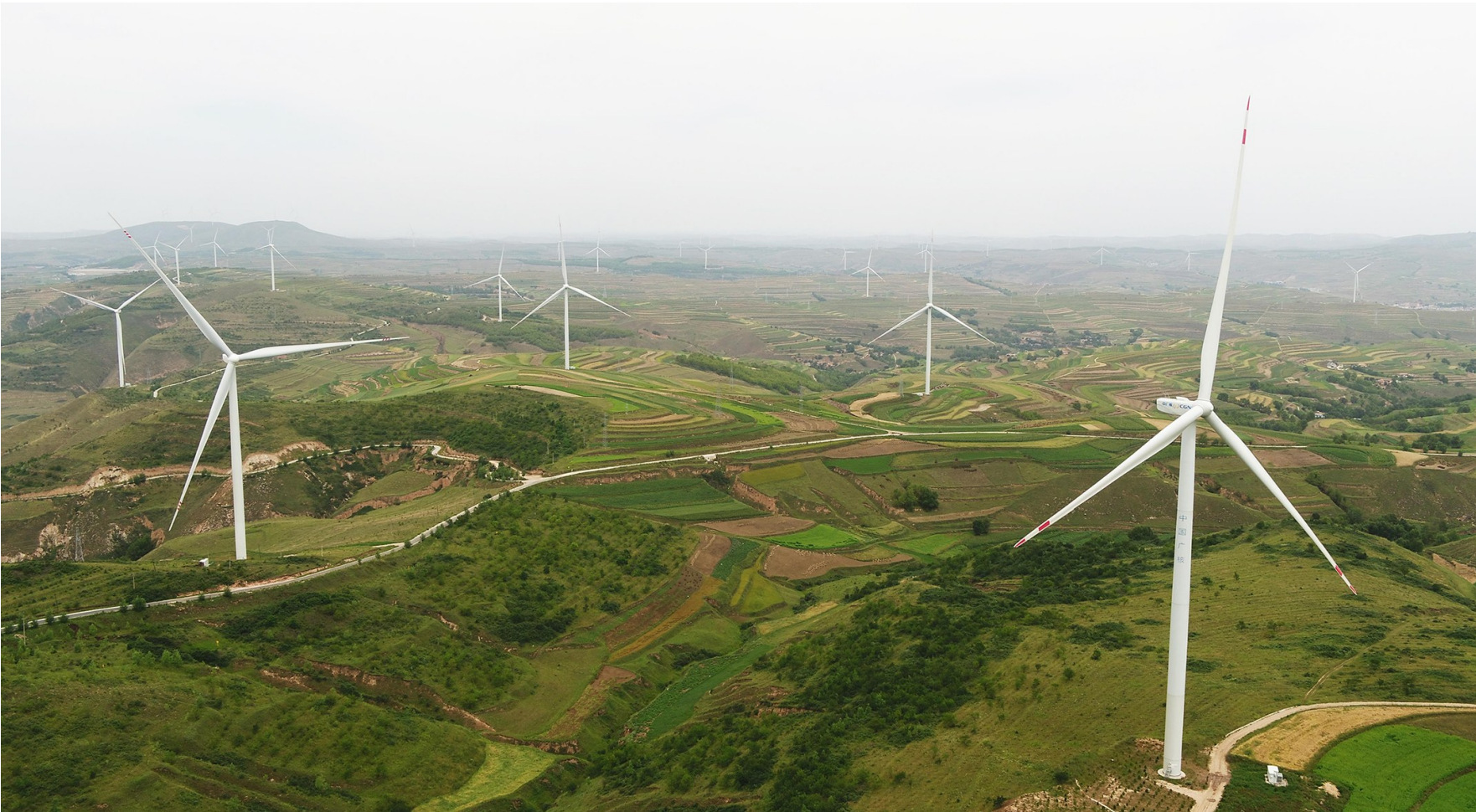
7月26日在甘肃省定西市通渭县拍摄的风机(无人机照片)。 夏日时节,在位于黄土高原的甘肃省定西市,风电基地风机迎风旋转,与梯田、村庄相映成景,蔚为壮观。 近年来,定西市充分利用黄土高原资源优势,大力发展风电、光伏为主的新能源产业,着力打造的通渭风电基地以通渭县为核心区,辐射周边多个区县,是陇中地区首个百万千瓦级风电基地。
