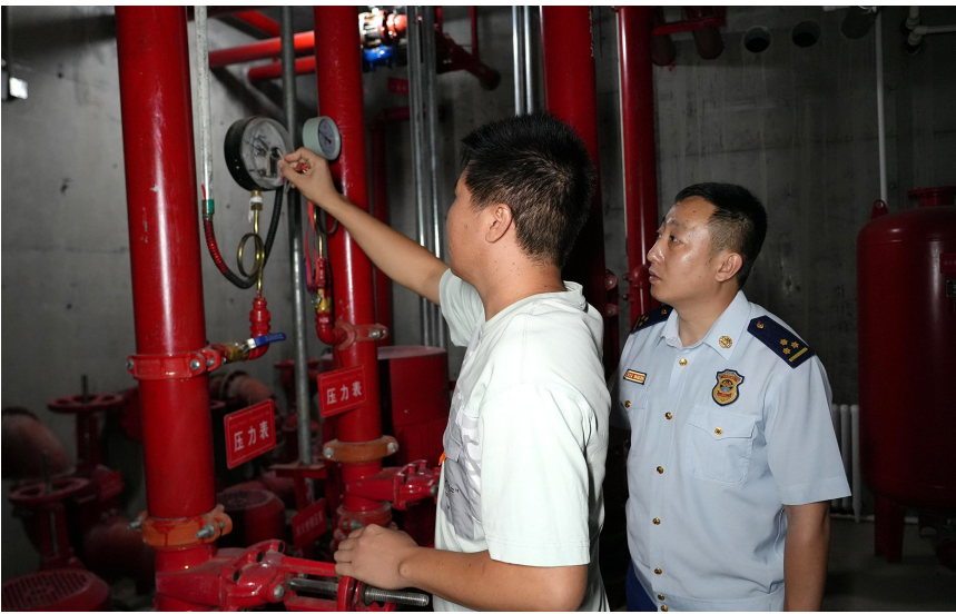
8月22日,检查组在昌吉州行知学校开展消防安全检查。
