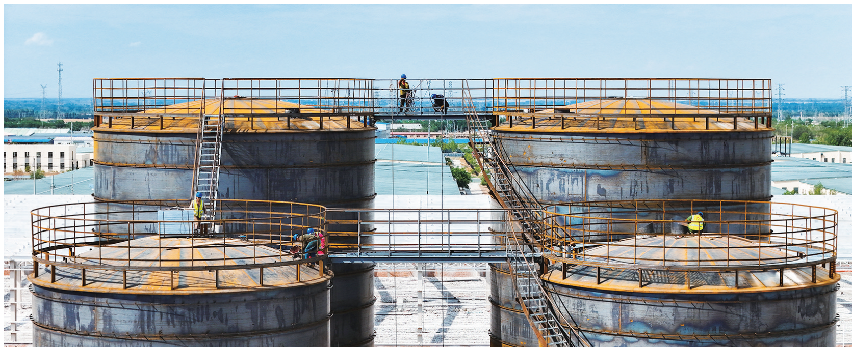
8月20日,在呼图壁天康植物蛋白有限公司脱脂棉籽蛋白生产加工项目建设现场,工人正在加紧施工。该项目将新建年加工20万吨光棉籽生产脱脂棉籽蛋白生产线,计划今年10月正式投产运营。项目投产后,可加工棉籽油2.66万吨、脱脂棉籽蛋白7.6万吨、棉壳9万吨,年产值约8亿元。
