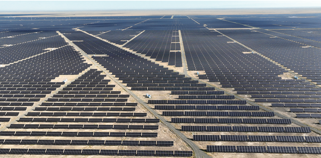
木垒县规划整齐的光伏区。
