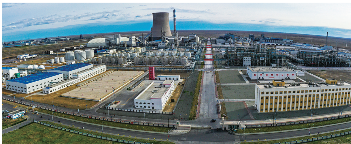
国泰新华厂区。
