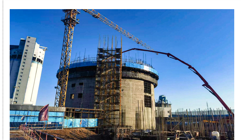
8月25日，中煤建设集团新疆分公司宜化矿业项目部施工现场，正在进行筒仓滑模施工。据悉，该项目共有4个施工筒仓，单个筒仓直径30米，设计储量3万吨。近年来，该公司积极组织各类骨干技术人才前往淮东各项目实施现场，保证高质量完成设计要求，为淮东经济技术开发区企业高质量发展作出贡献。 □张福军摄
