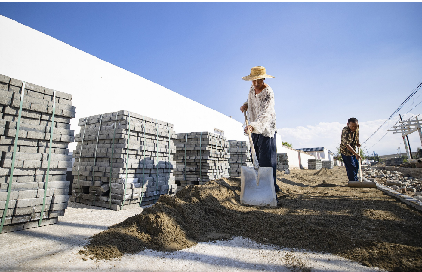
8月28日，在吉木萨尔县老台乡梭梁村道路硬化施工现场，工人们正在平整路基。近年来，老台乡大力推进乡村基础设施建设，通过修复道路、铺设彩砖、场地平整等，提升老台乡整体形象，为群众提供更加安全畅通的出行环境。 □本报记者 巨海成摄
