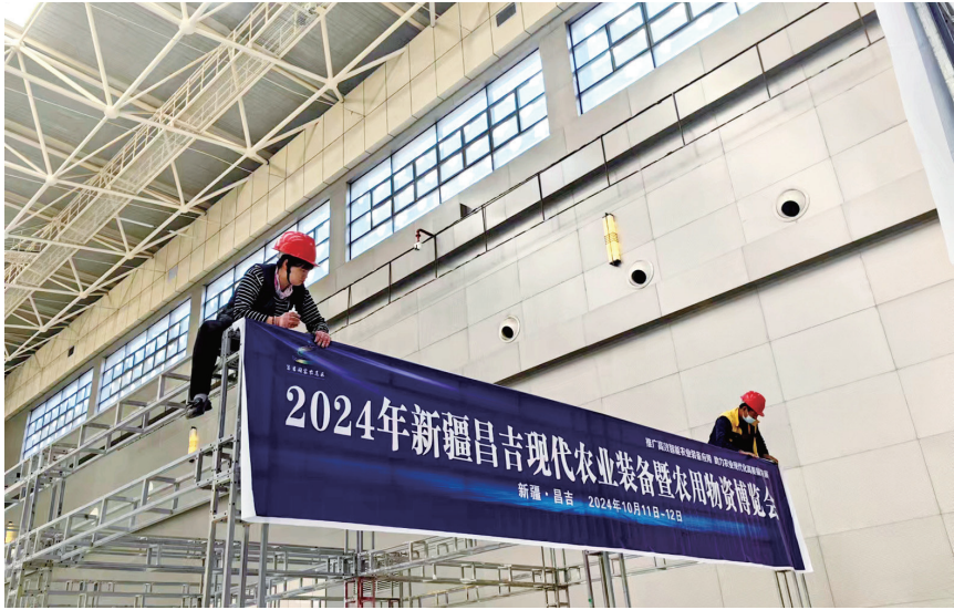
10月10日，昌吉国际会展中心展馆内，工人在安装展架。□本报记者 王薇摄
