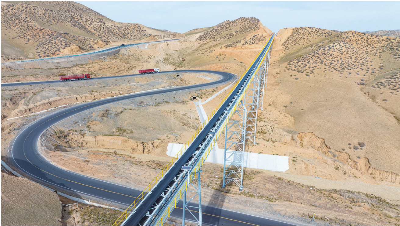
10月15日,呼图壁县九洲恒昌输煤廊道项目落成投运。该廊道全长34.5公里,是新疆目前输送距离最长的廊道,年运量700万吨。 □本报记者 何龙摄
