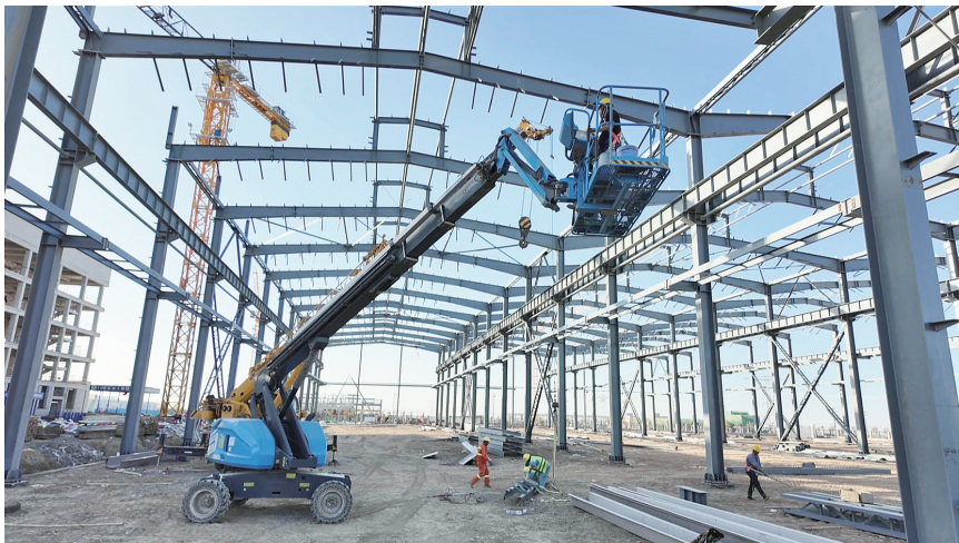
10月15日，在木垒县新能源高端装备制造产业园，一新能源项目正在施工。 □本报记者 常谊谊摄
