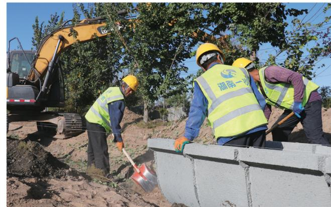
10月10日,呼图壁县二十里店镇良科村末级渠系项目施工现场,工人在砌筑U型板。今年,呼图壁县投入4.3亿元,对404.7公里末级渠系进行改造。目前,全县各乡镇末级渠系改造工程建设已全面铺开,预计11月中旬全部完工。 □宋凯琪摄
