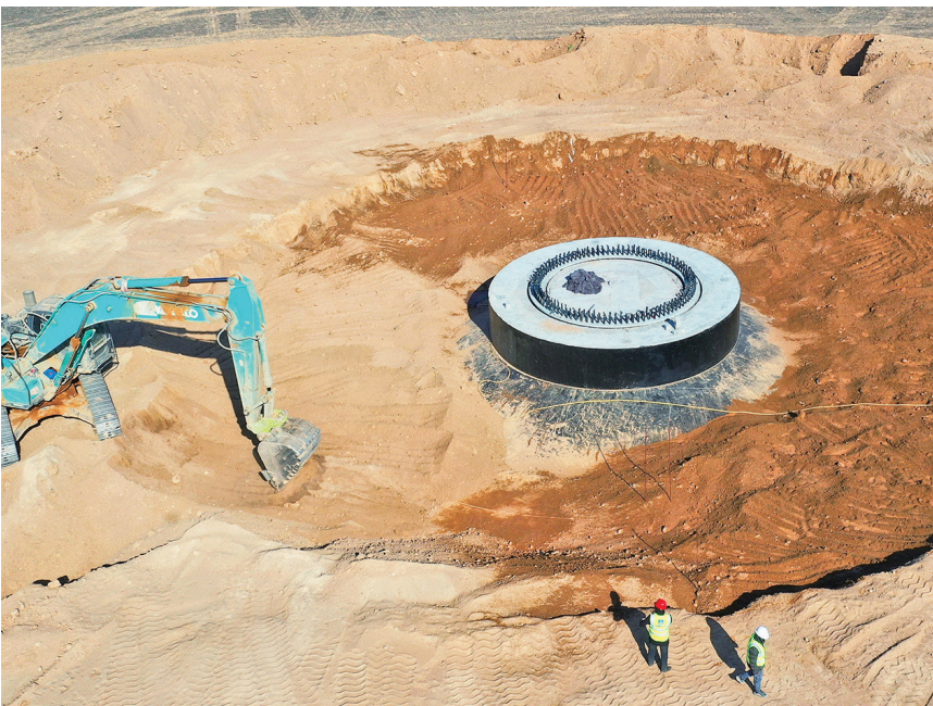
10月23日,新疆其亚新能源有限公司300万千瓦风光电项目建设现场。 □本报记者 常谊谊摄 地考察和磋商,拥有优渥风光资源的木垒县被其成功锚定,其亚集团加快入局新能源产业“赛道”。 “风光资源取之不尽、用之不竭,且属于零排放、零污染的天然绿色电力,发电成本低于火电,借助风光电合并自
