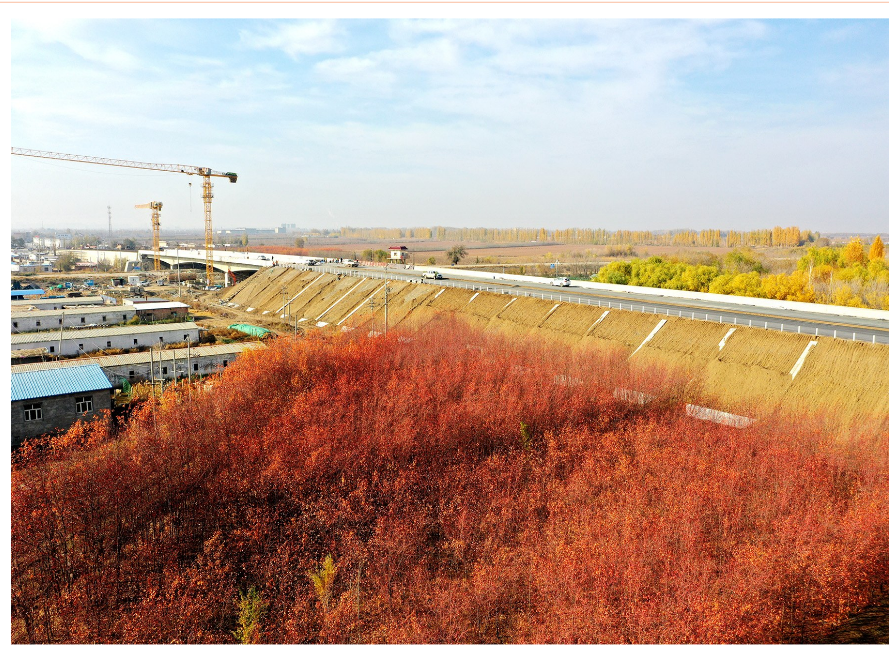
S231线五家渠至昌吉公路改扩建项目即将完工。项目起点位于昌吉市六工镇沙梁子村与S102线交叉口，终点位于老路S231线与电台路交叉口，全长11公里，总投资3.36亿元。全线采用一级公路设计标准，双向六车道路面宽敞平坦。 截至目前，项目的各项工程都在稳步推进。路基填筑累计完成61万m³，完成总量的93%；路面水稳基层累计完成5公里，完成总量的46%；沥青面层已完成1.5公里，完成总量的14%；K1+700,500干渠大桥下部结构完成100%，上部结构完成94%。施工单位正紧锣密鼓抓住最后的黄金施工期，力争分秒地加快施工进度，力求按时、高质量地完成项目建设。预计在11月30日，这条崭新的公路将正式通车。图为11月1日航拍的S231线五家渠至昌吉公路改扩建项目现场。
