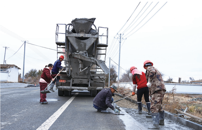
近日，吉木萨尔县泉子街镇太平村和小西沟村人居环境提升项目施工现场，工人在铺设人行道。
