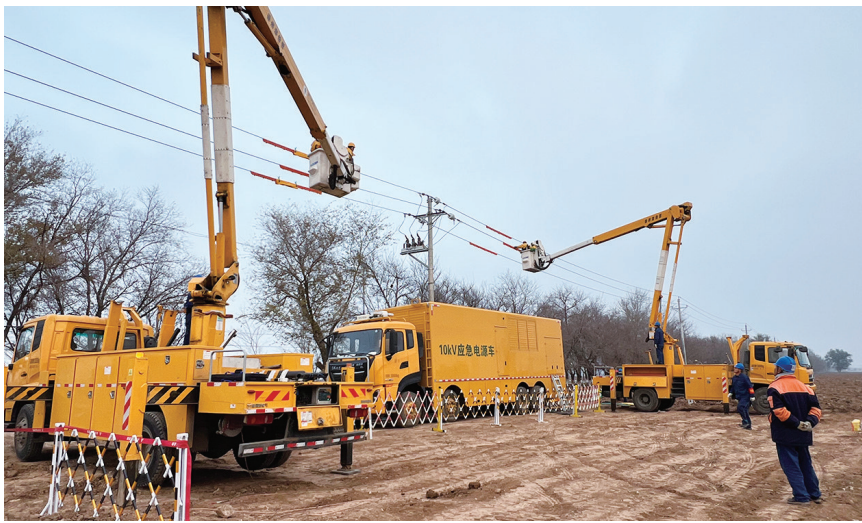
11月12日，在昌吉市榆树沟镇前进村五片区和六片区10千伏建乡线施工现场，一台3000千伏安中压发电车与一台1000千伏安中压发电车同时并网作业，实现电网改造和供电保障两不误。
