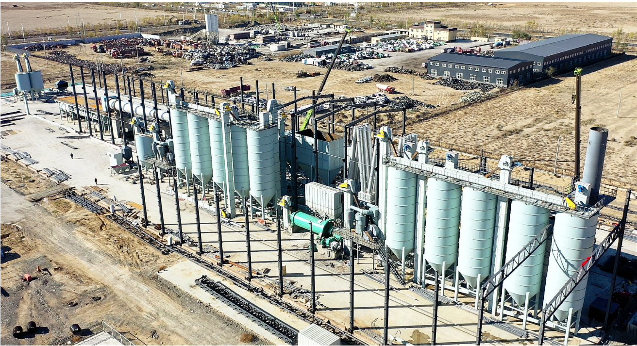
11月18日,新疆桂新环保科技有限公司年产20万吨铝酸钙项目建筑工地,机械设施在作业。
