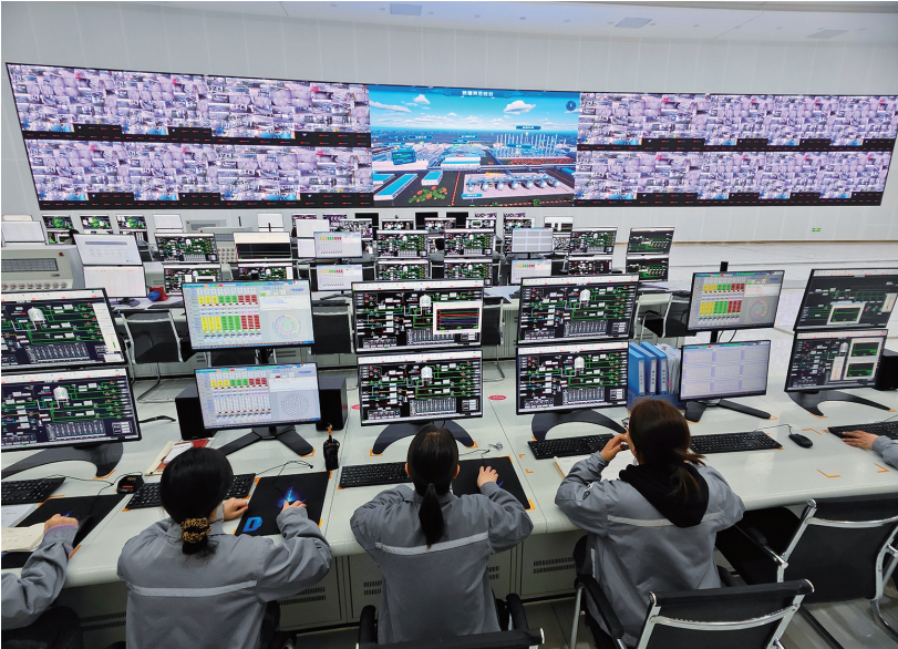
新疆其亚硅业有限公司智能中控室，工作人员正在操作记录多晶硅生产情况。 □本报记者 常谊谊摄
