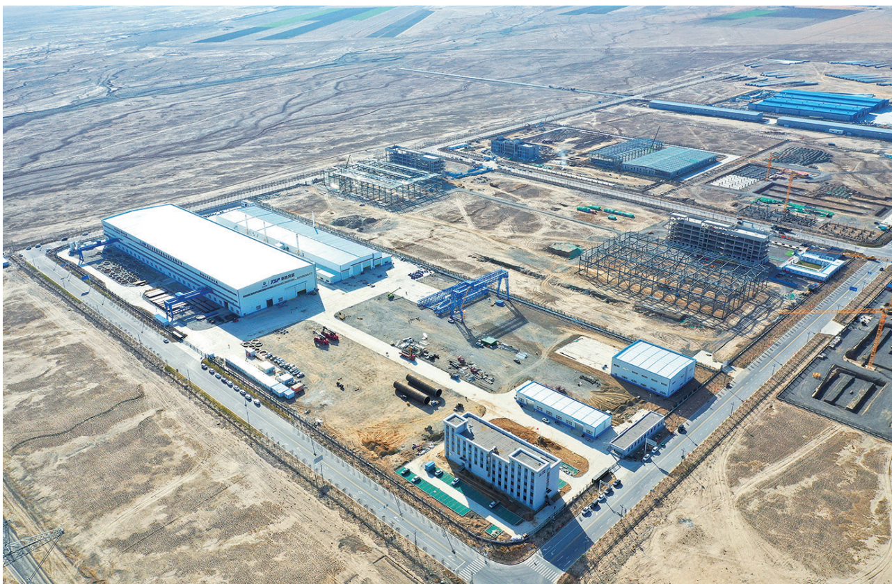
图为泰胜风能风电设备有限公司年产10万吨风电塔架项目现场(资料图片)。
