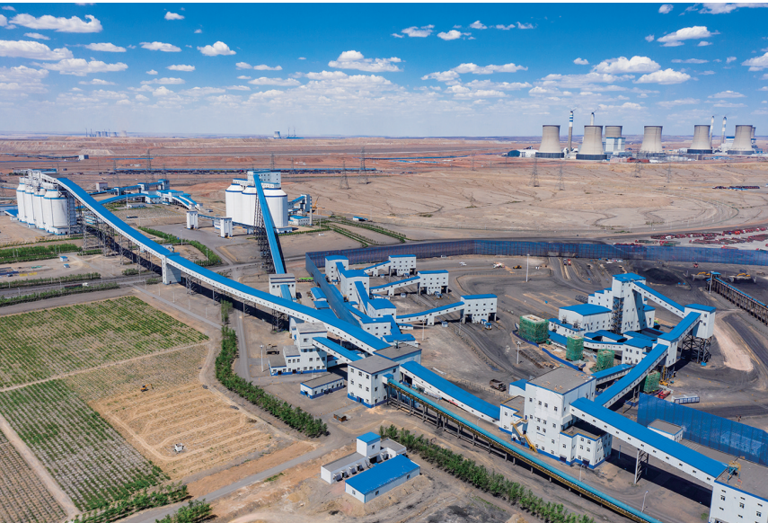
图为新疆天地能源有限责任公司南露天煤矿的全链智慧套索式筛分楼和室内分选站，全过程生产环节煤不落地，降低环境及土壤污染。
