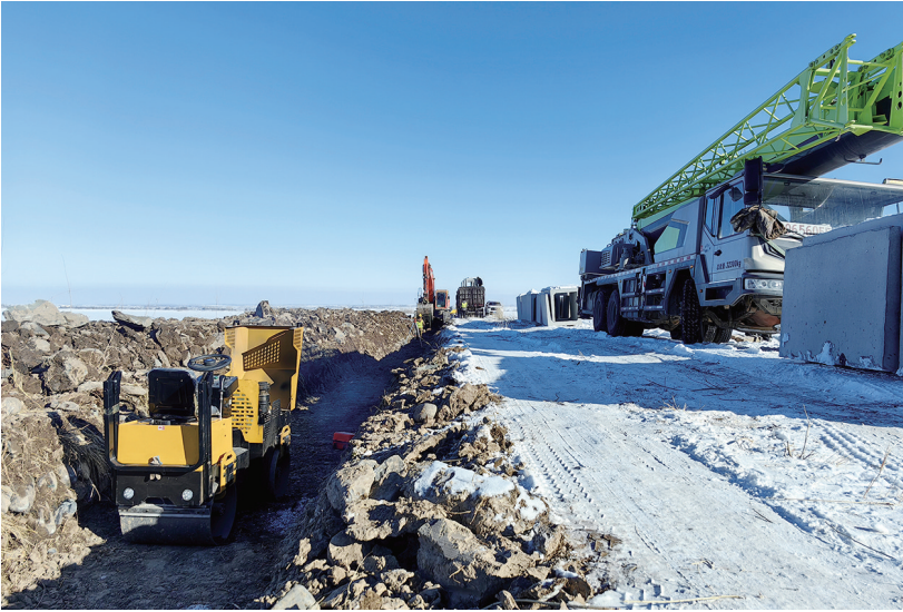
2024年12月26日，奇台县新建末级渠系改造建设项目塘坊门村段施工现场，挖掘机的开沟作业。
