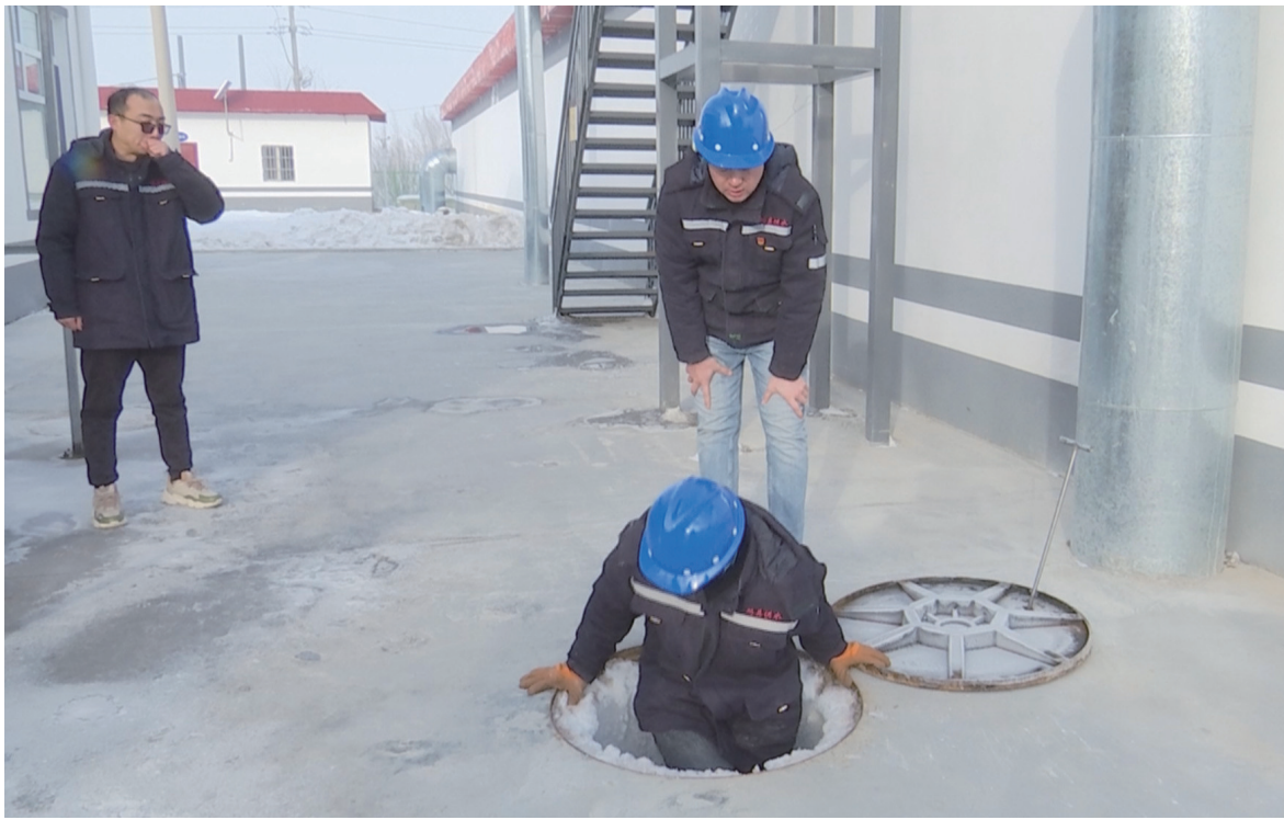
春节期间,玛河水务工作人员对供水管道进行日常检修。
