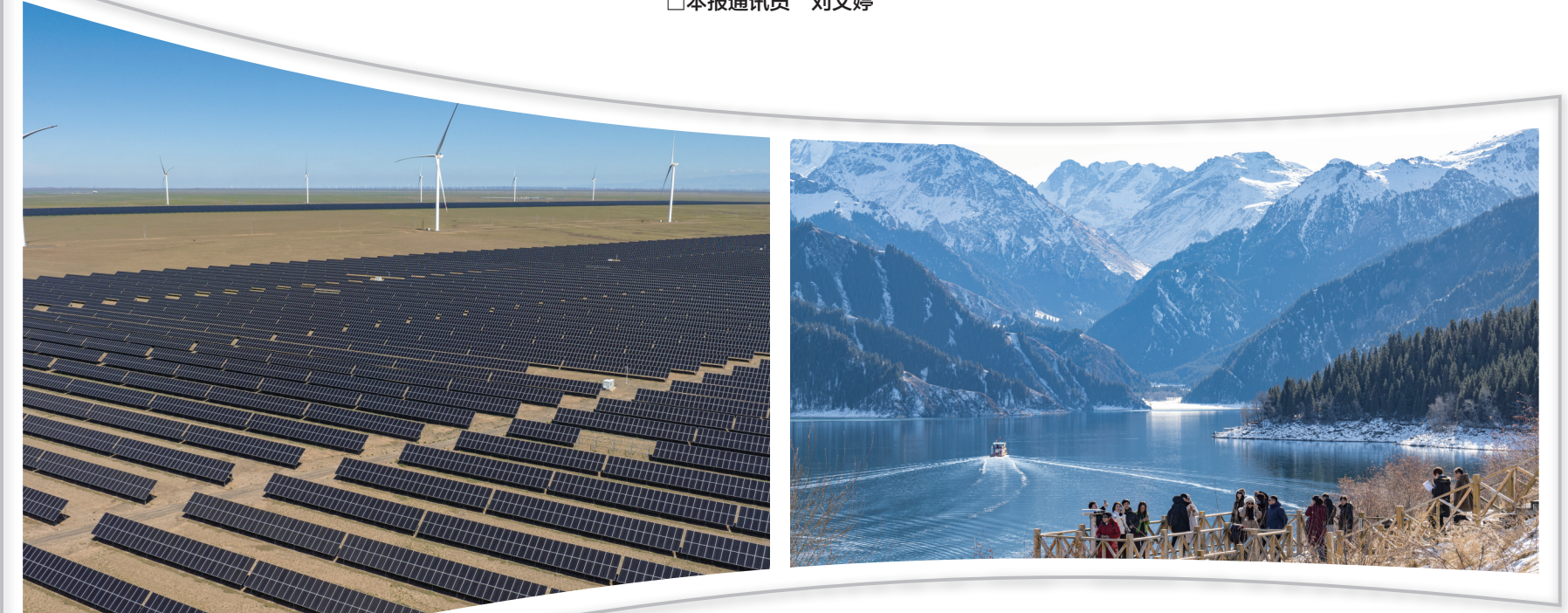
图为木垒县雀仁光伏园区内，光伏项目正常运营中。
