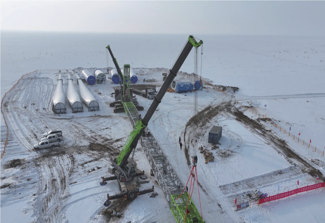
2月17日，木垒县博斯坦风电规划区第一风电场中煤古尔班通古特沙漠基地40万千瓦风电项目现场，工人正在进行风机吊装的准备工作。
