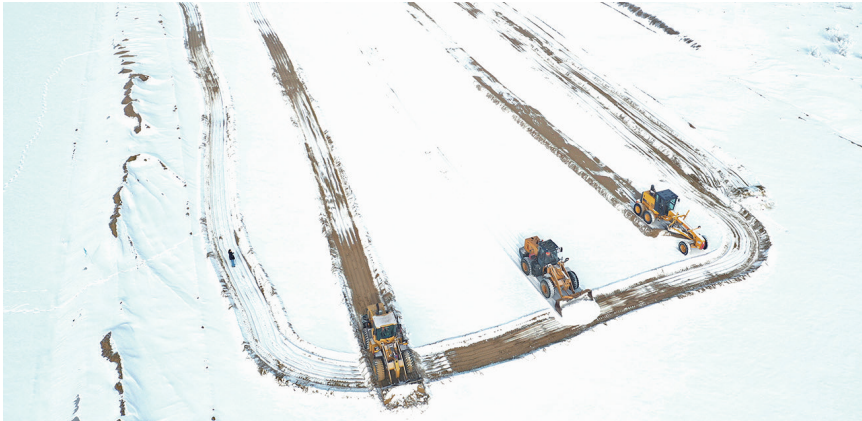
2月20日,大型机械正在新疆准东五彩湾通用机场飞行区场道及目视助航工程项目现场施工作业。
