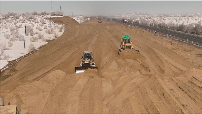
S239线五彩湾至吉木萨尔县公路改扩建项目施工现场,推土机正在进行土方作业。 □马凯雄摄
