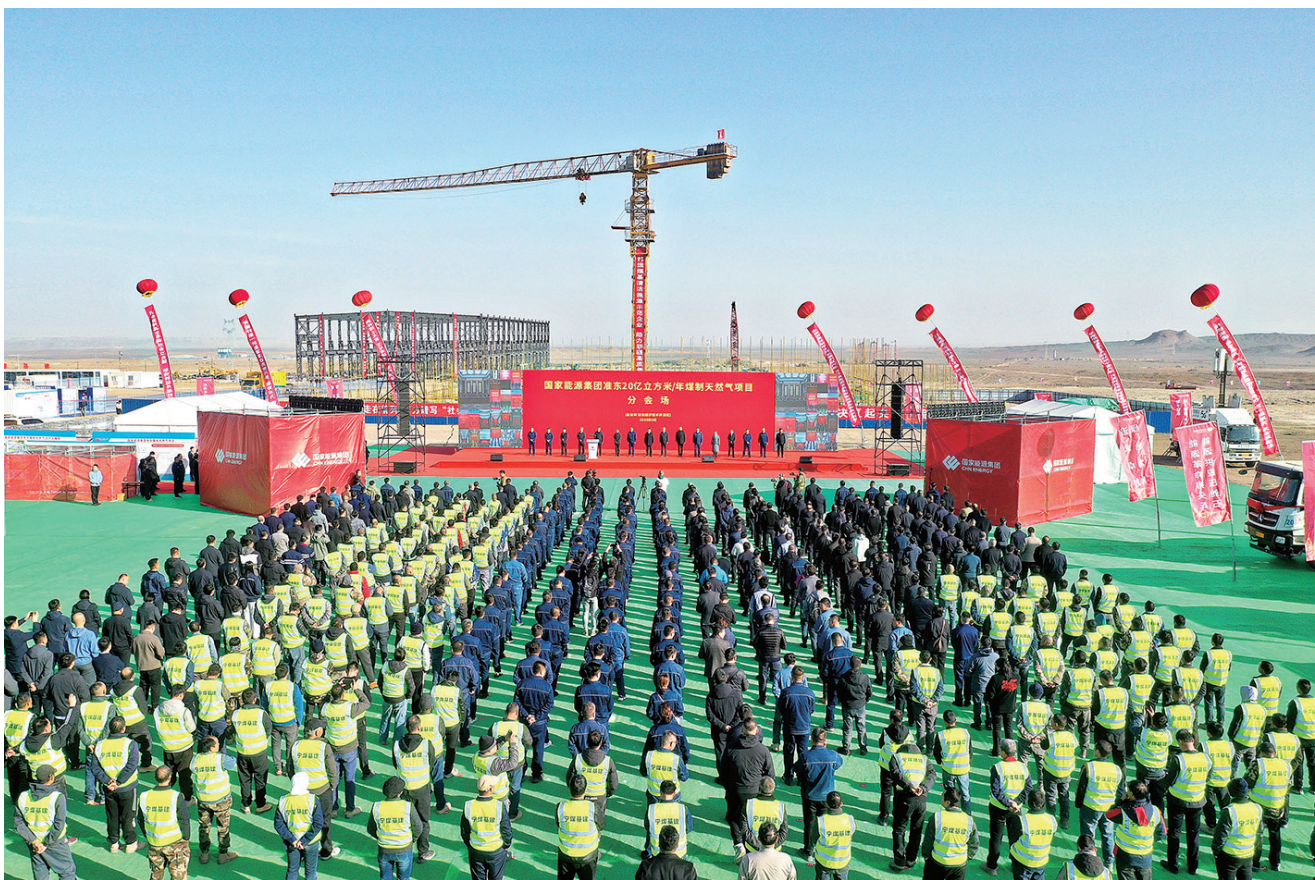
3月22日,国家能源集团准东20亿立方米/年煤制天然气项目正式开工。
