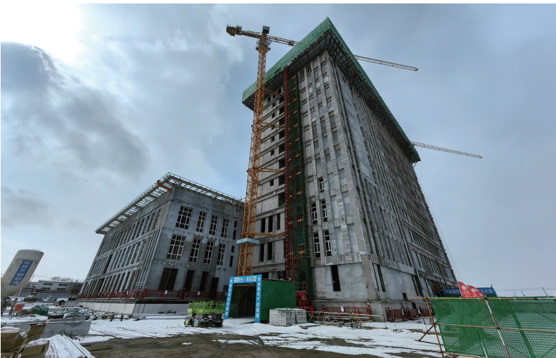
阜康市中医医院新院区建设项目施工现场。 □本报记者 高云哲摄
