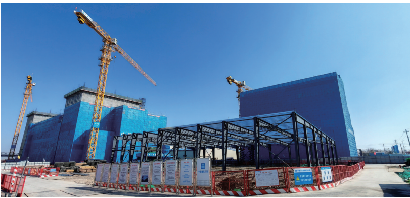
中粮八一面业(呼图壁)有限公司年加工30万吨小麦扩建项目施工现场。 □本报记者 岳文玲摄
