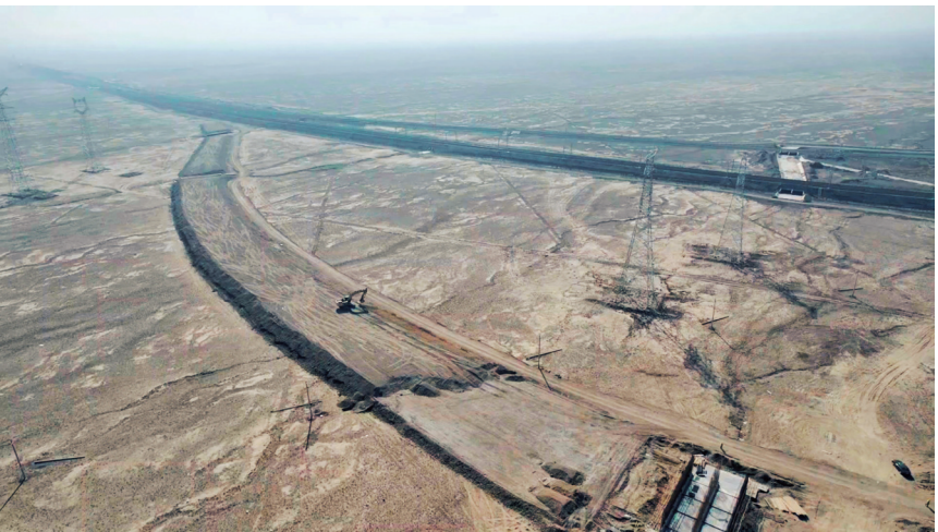
阜康市下南泉铁路专用线项目建设现场。
