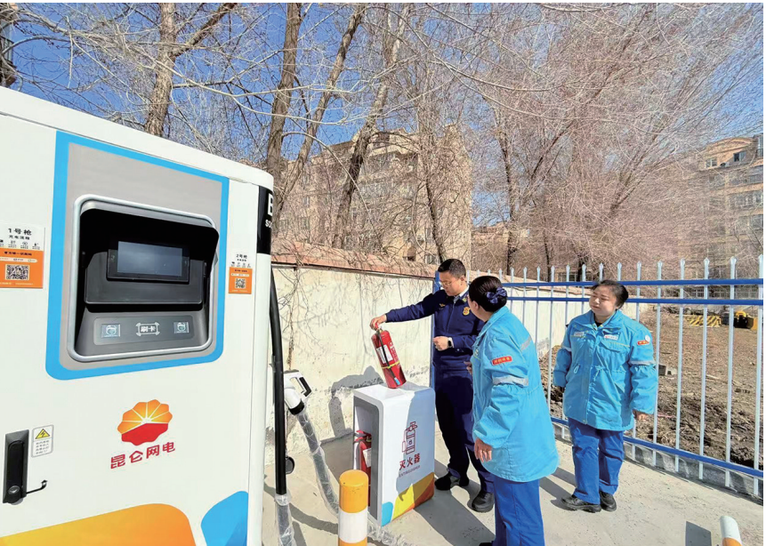
4月2日，昌吉农高区消防救援大队防火监督员检查辖区加油站充电桩区域的消防器材。 □邢淑新摄
