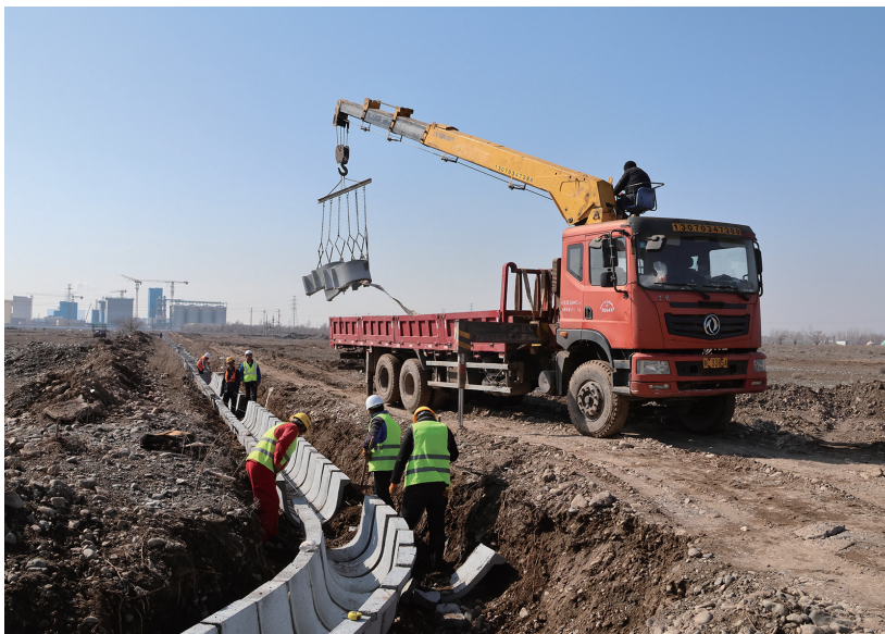
呼图壁县五工台镇十户村施工现场，工人正在加紧铺设渠板。 □宋凯琪摄
