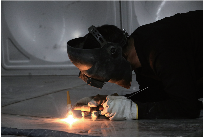
4月8日，新疆襄新畜产品有限公司项目建设现场，施工人员正在焊接设备。 □刘玉洁摄
