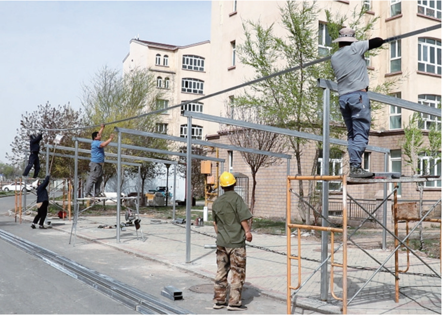
4月14日，在呼图壁县大丰镇新丰社区馨丰花苑小区，工人正在搭建电动自行车充电车棚。 □刘玉洁摄
