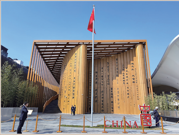
占地面积约3500平方米的中国馆,是大阪世博会最大的外国自建馆之一。
