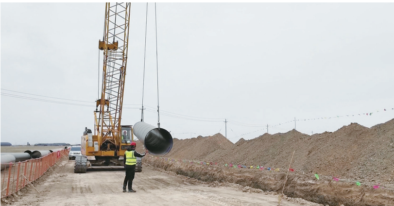
吊车向管内吊放涂塑钢管。
