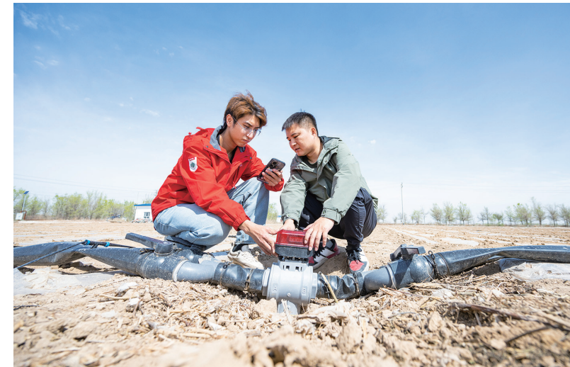
4月18日,昌吉国家农业高新技术产业示范区智慧农场,新疆慧尔智联技术有限公司技术人员在调试智慧电动灌溉球阀。
