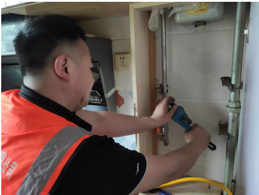
右图:近日,施工人员在居民家安装管道燃气自闭阀。 □贾兴旺摄
