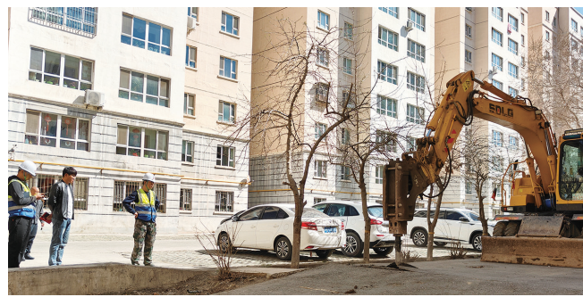
合兴丽锦小区改造现场。
