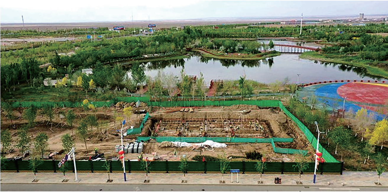
准东湿地公园新增东西地块绿化项目正在加紧施工。
