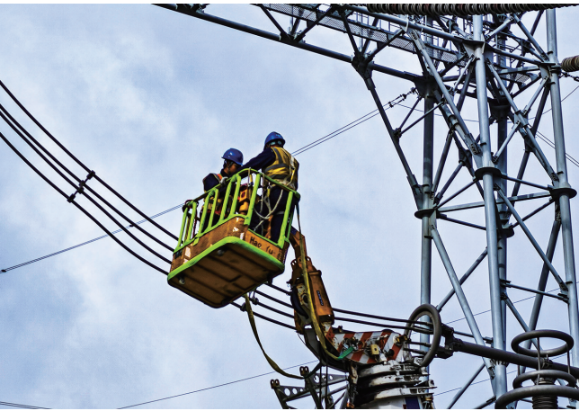
“疆电东送”昌吉换流站工作人员正在进行高空检修。
