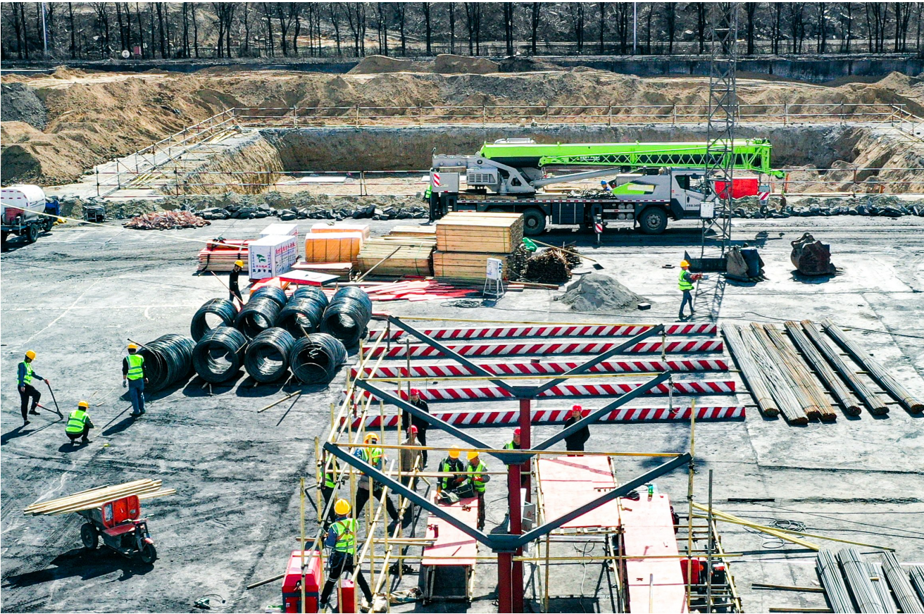
5月19日,位于呼图壁县石梯子乡的新疆黑石碳科有限公司600万吨/年清洁煤项目建设现场。
