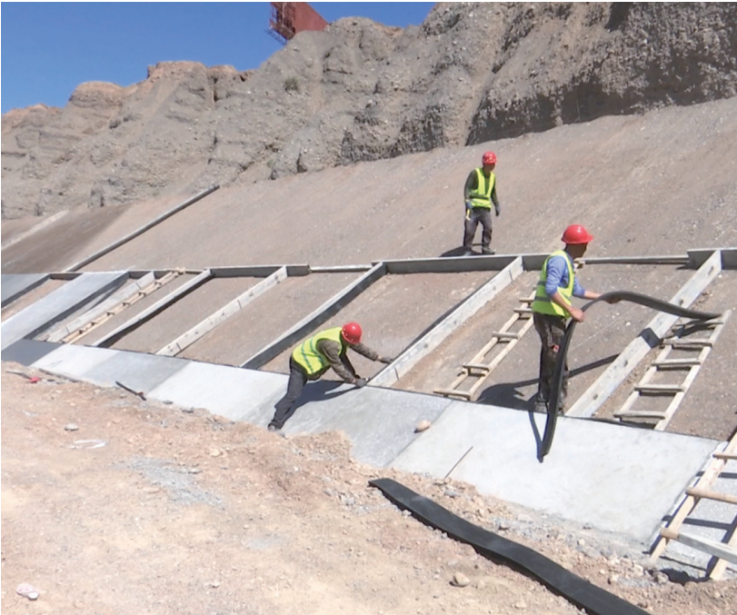
工人在昌吉市大洪沟浇筑河岸面板。
