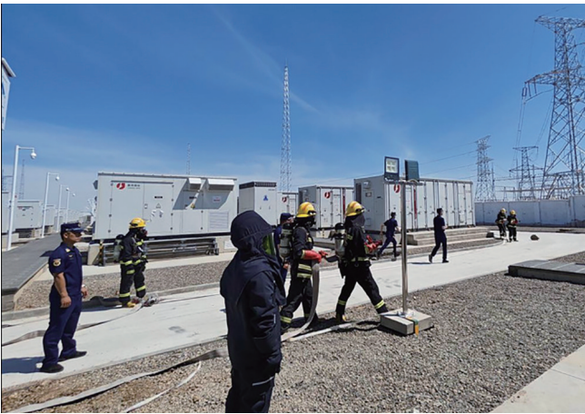
图为应急演练现场,变电站工作人员联合阜康市消防大队消防指战员进行现场处置。
