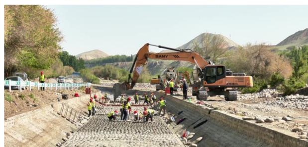
图为在玛纳斯县塔西河乡项目施工现场，工人进行浆砌石底板铺设作业。 □朱文斌摄
