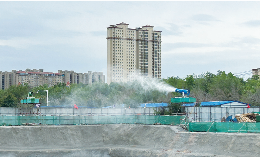
图为昌吉州市工人文化宫项目施工现场,智能降尘喷淋系统在喷洒水雾。 □马玉娇摄
