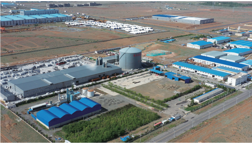
阜康市长津新材料科技有限公司航拍图。
