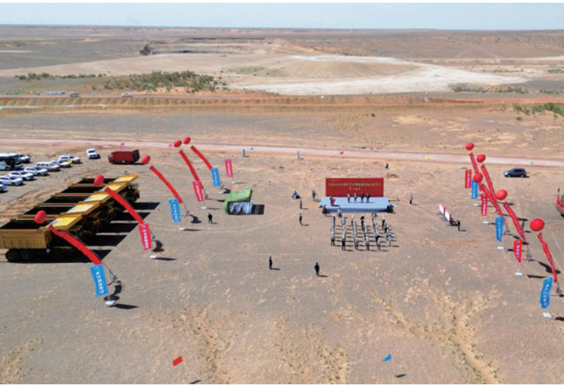
新疆准东东部矿区专用铁路及物流园项目开工仪式现场。
