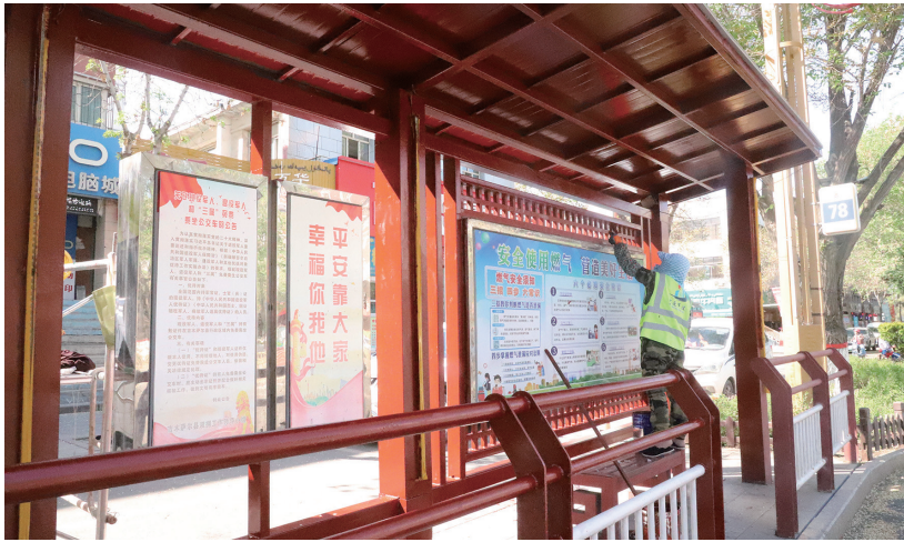
图为工人对公交站台进行喷漆翻新。
